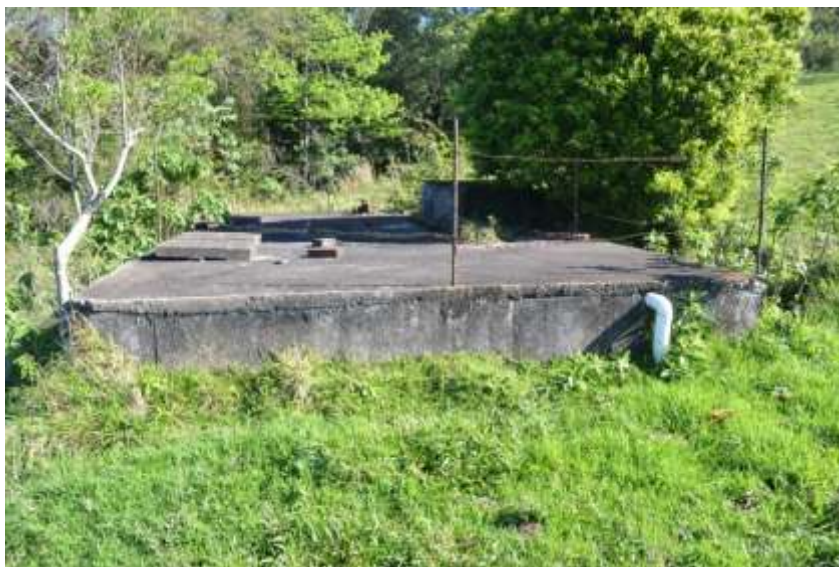
Figura 26 – Reservatório Vale Vêneto
