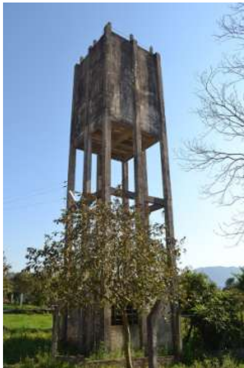
Figura 50 – Reservatório Vila Ceolin
