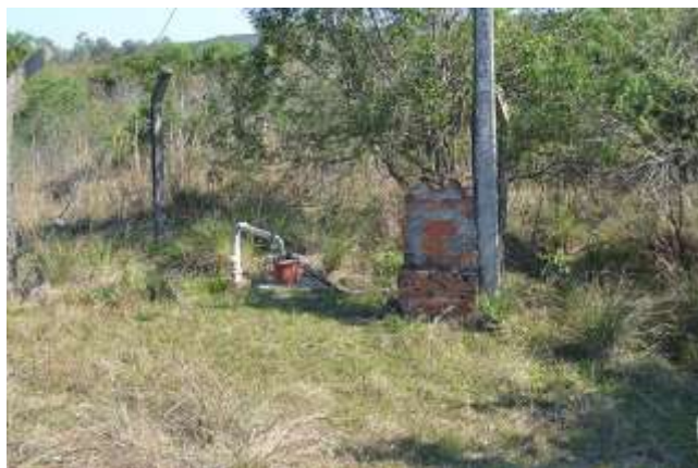
Figura 43 – Poço Artesiano Linha São Francisco
