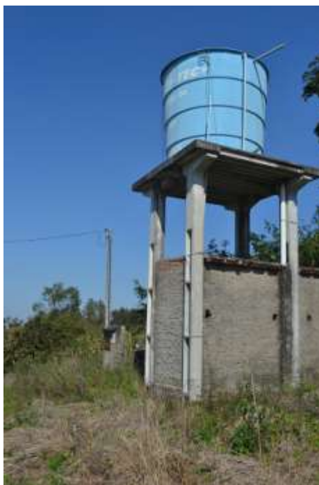
Figura 52 – Reservatório Vila Nova São Lucas
