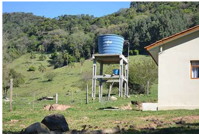
Figura 42 – Reservatório Linha Santana
