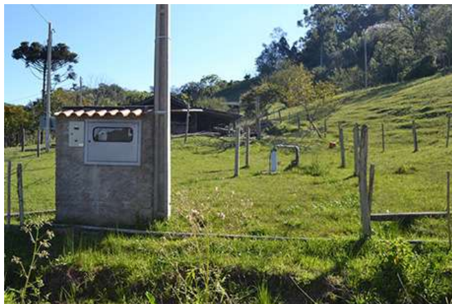
Figura 47 – Poço Artesiano São Valentin
