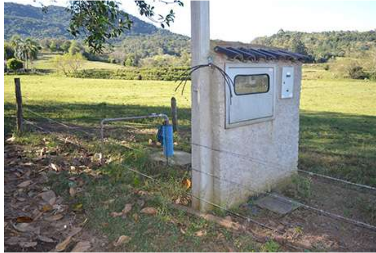
Figura 33 – Poço artesiano Linha da Glória
