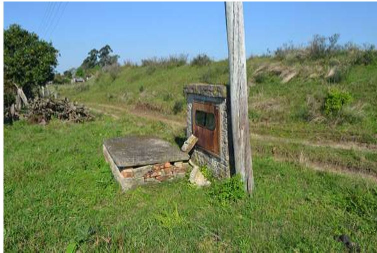
Figura 49 – Poço Artesiano Vila Ceolin
