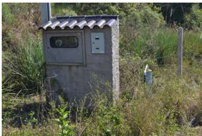
Figura 39 – Poço Artesiano Linha do Monte
