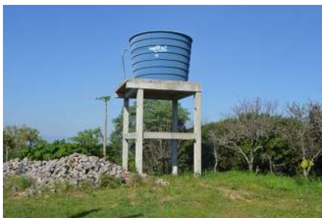
Figura 40 – Reservatório Linha do Monte
