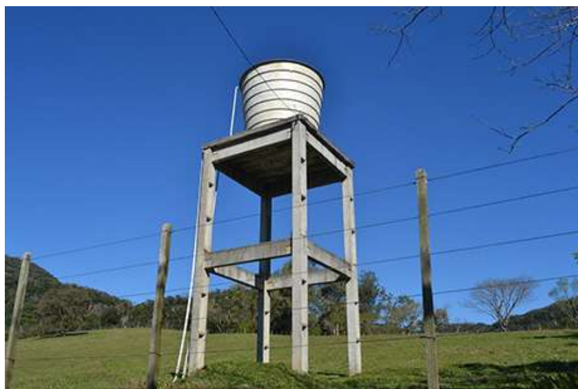
Figura 32 – Reservatório Linha Duas
