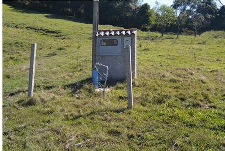
Figura 41 – Poço Artesiano Linha Santana
