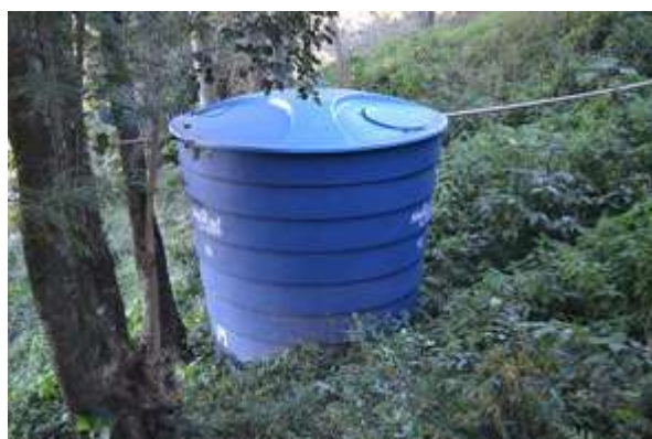
Figura 55 – Reservatório Linha do Monte (acesso a S. Martins)
