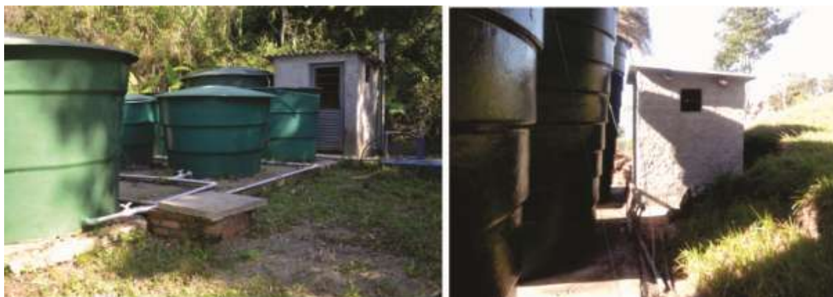
Figura 28 – Reservatórios Recanto Maestro
