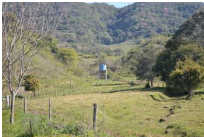
Figura 36 – Reservatório Linha Bom Fim
