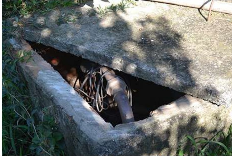
Figura 29 – Poço artesiano Caravel
