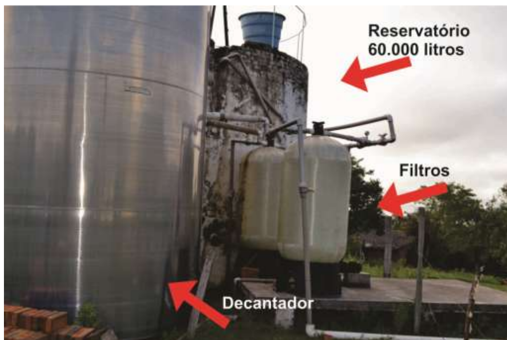
Figura 25 – Reservatório de 60.000 litros – filtros e estação de decantação
