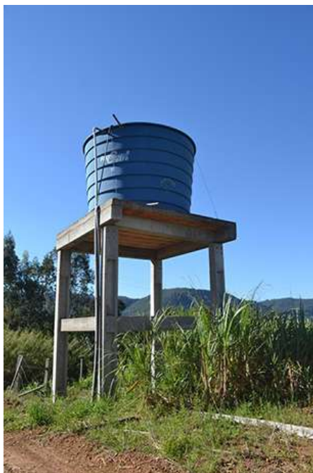
Figura 48 – Reservatório São Valentin
