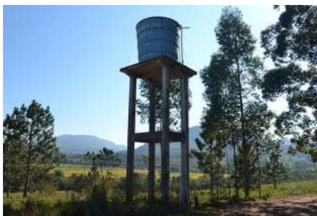
Figura 44 – Reservatório Linha São Francisco
