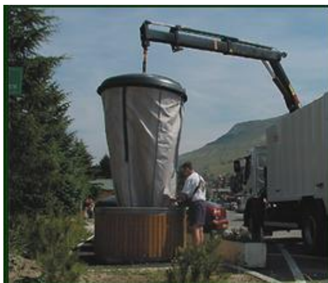
Figura 37: Recolhimento dos resíduos.
